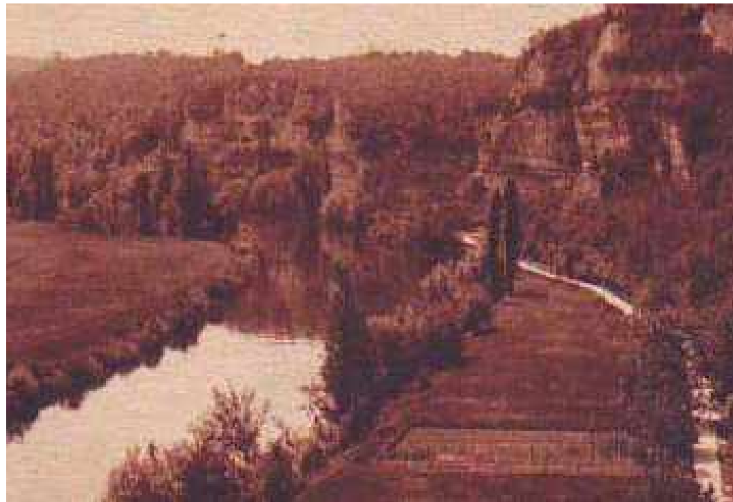
Figure 3 : Le Grand Roc et Laugerie - vue années 60
