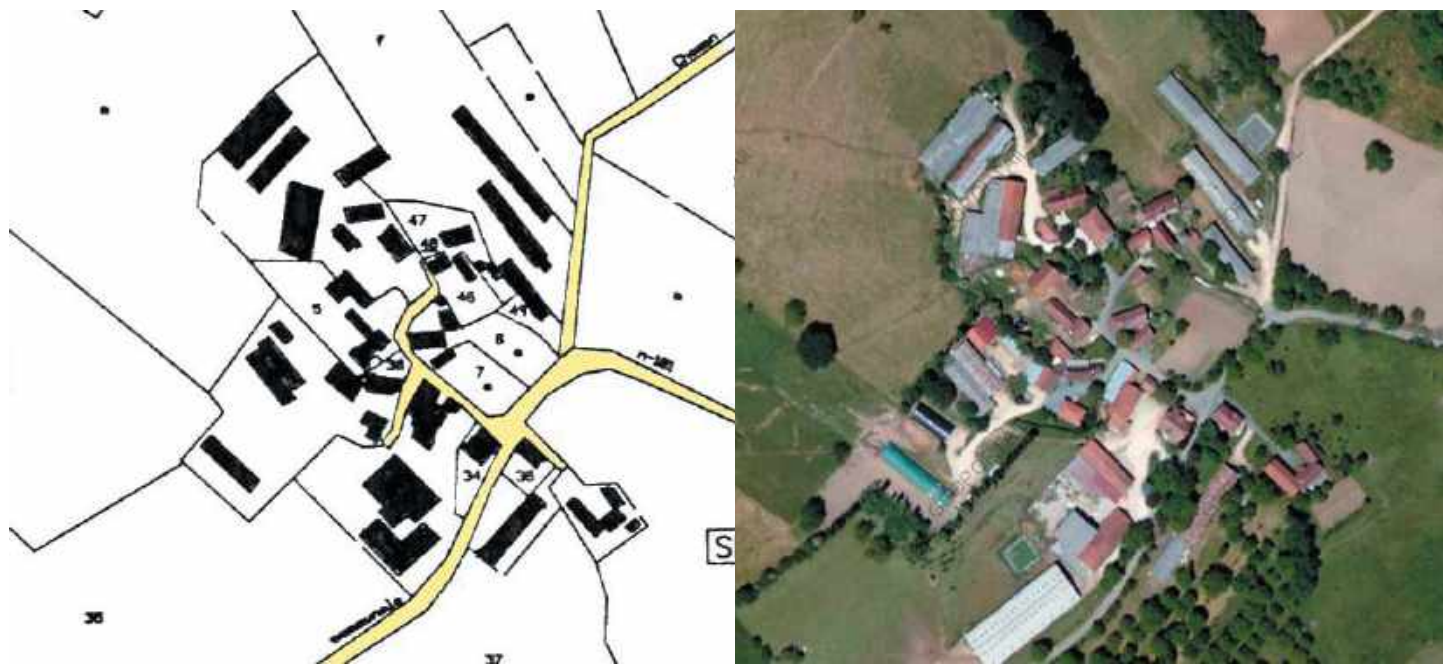
Figure 2 : Le petit Salignac - Cne de Tamnies Fermes regroupées au coeur du village, extension des bâtiments d'exploitation et d'élevage en périphérie
